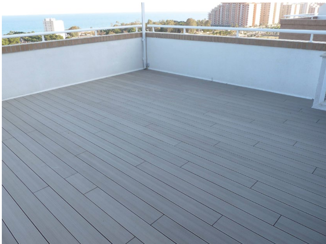
25. Tarima montada a junta perdida.
