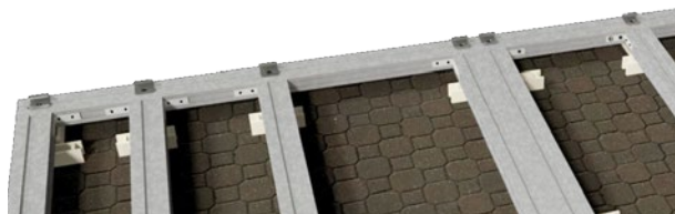
33. Inicio de instalación con clip de inicio.
