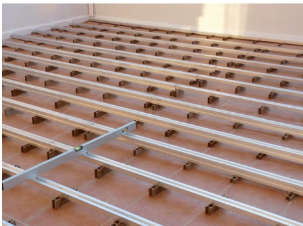
23. Rastrelado para junta perdida.
