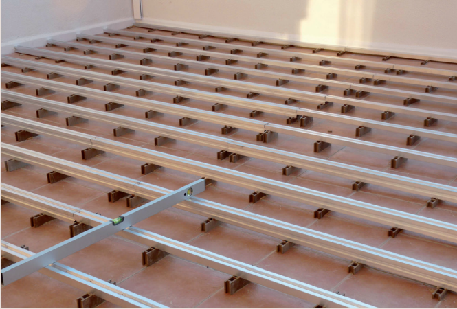
22. Rastrelado para junta perdida.
