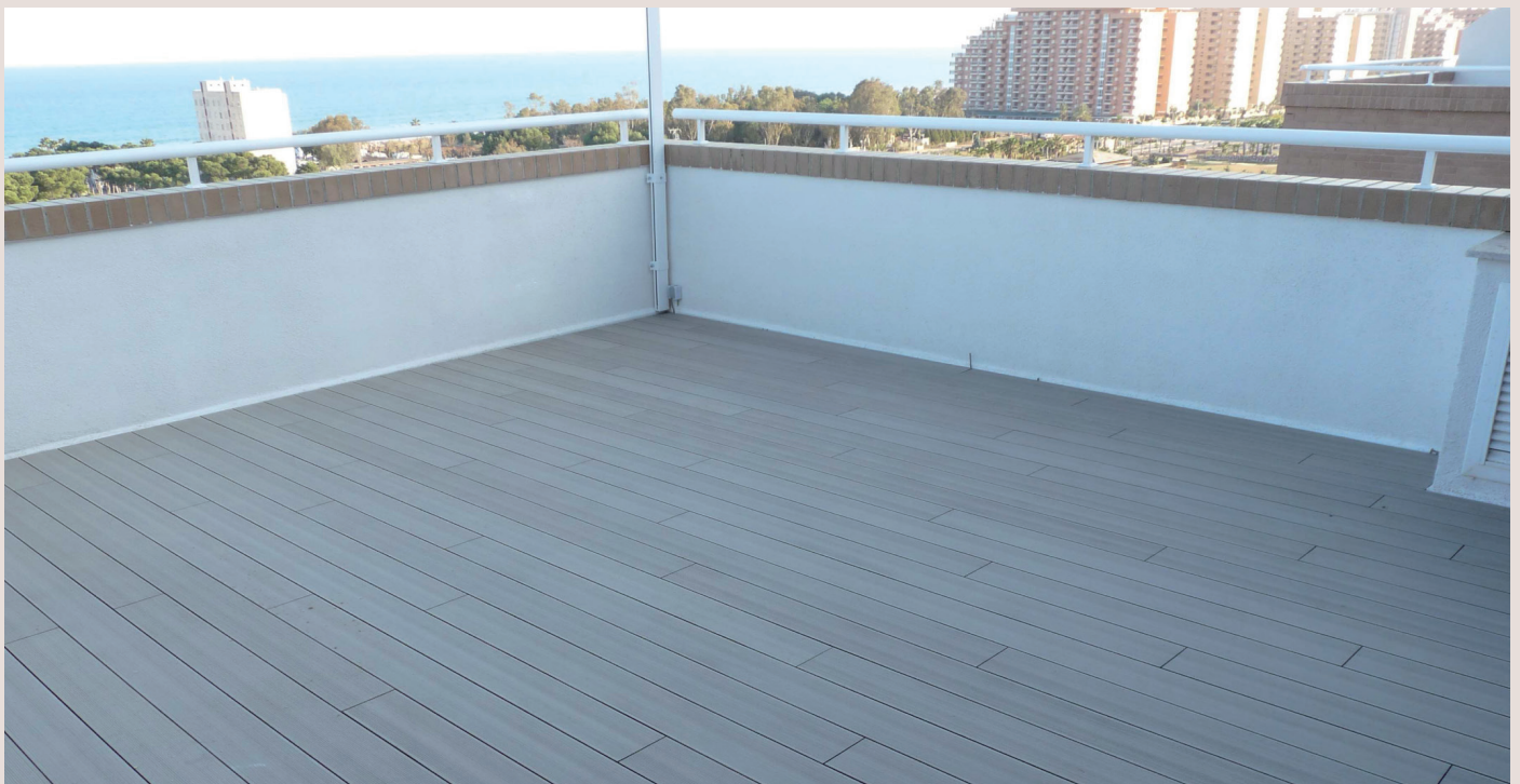
24. Tarima montada a junta perdida.
