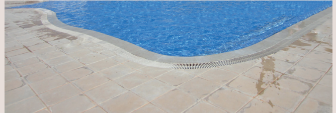
1. Piscina con suelo de hormigón, ejemplo de suelo apto para atornillar.
